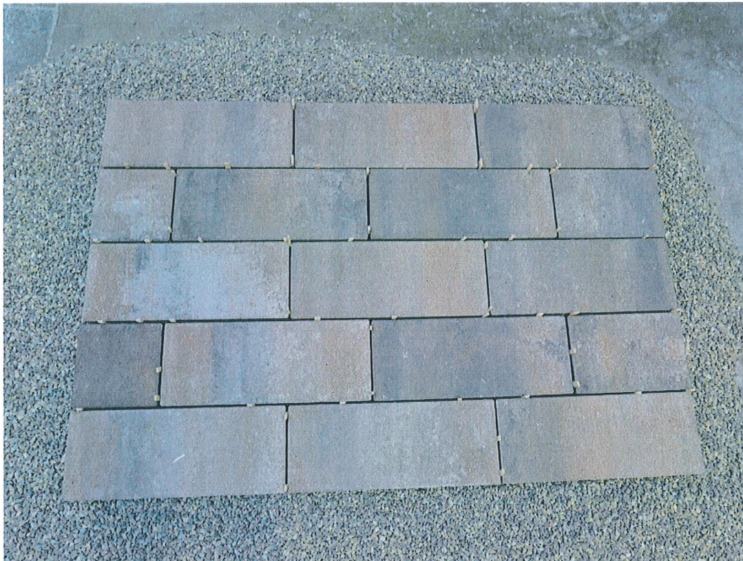
Bild 3: Versuchsfeld - Fugenbreite wurde mit 4 mm dicke Holzstreifen eingestellt
