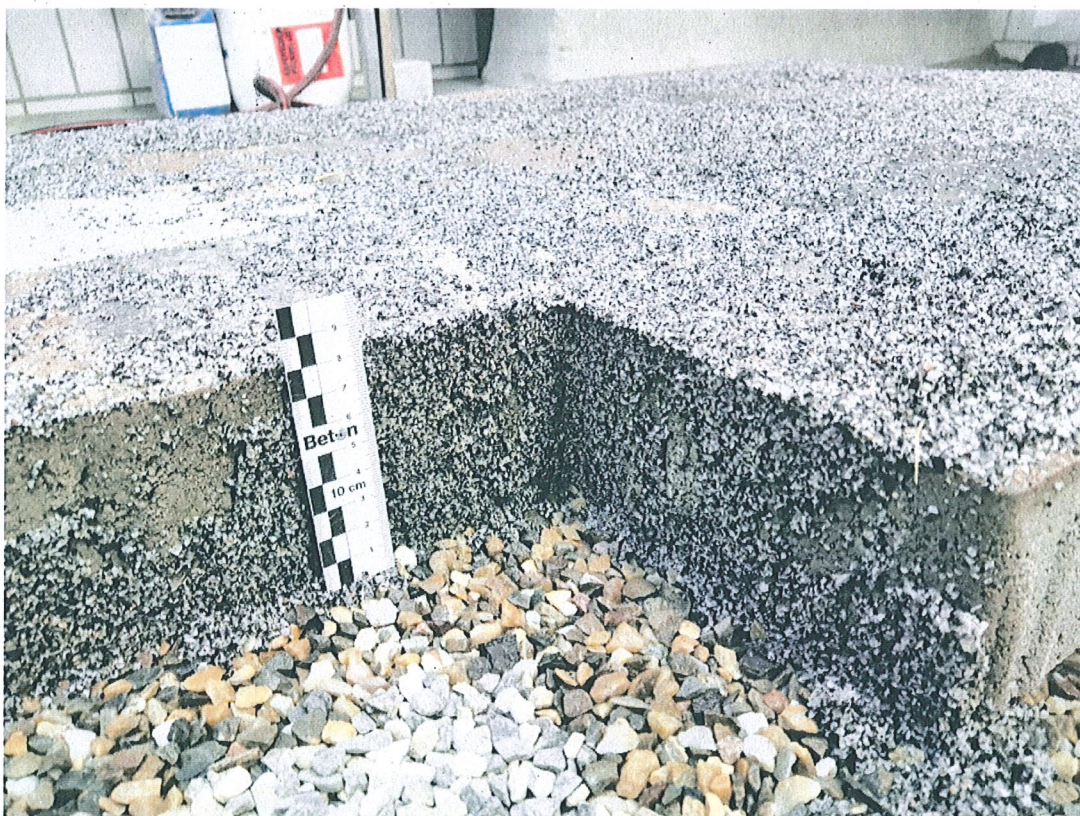
Bild 8: Detailansicht, Fuge nach Bewässerung
