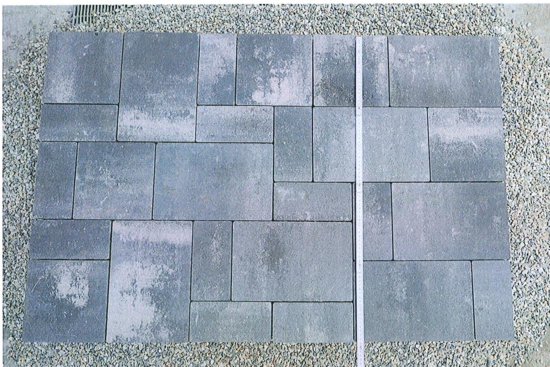
Bild 2: Vorgeschlagene Musterfläche des Betonpflastersystems "Rechteck-Pflaster", Steinhöhe 80 mm, verlegt im Läuferverband.
