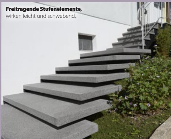
**Freitragende Stufenelemente**, wirken leicht und schwebend.
