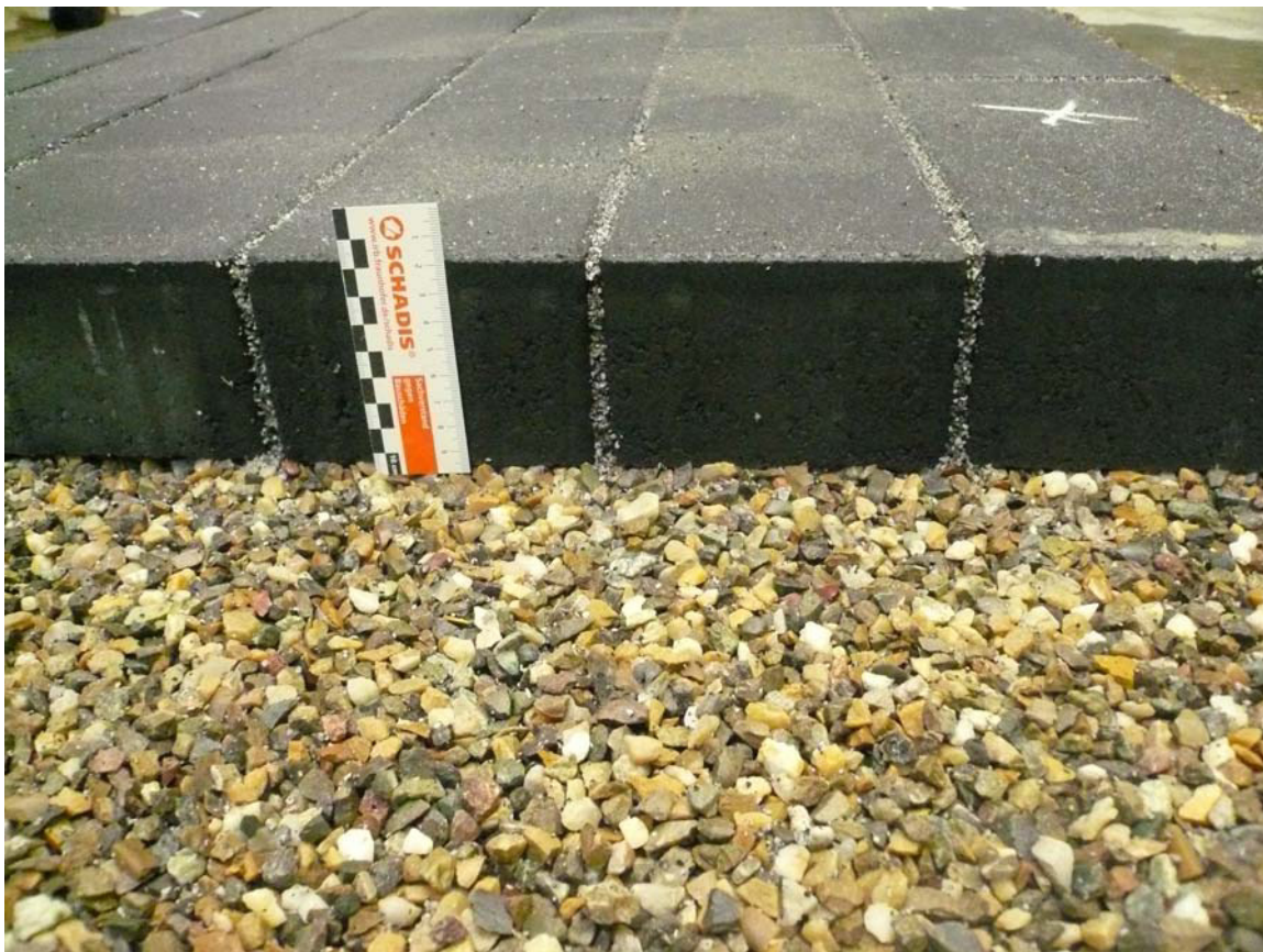
Bild 5: Detailansicht, Fuge nach Bewässerung
