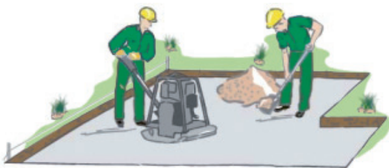
Tragschicht mit einem geeigneten Rüttler verdichten
