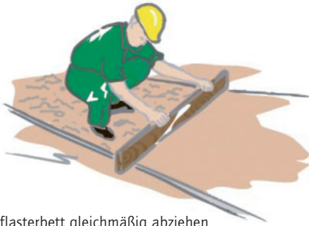
Pflasterbett gleichmäßig abziehen
