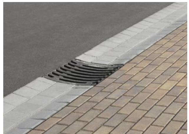
Verbundrinne , eignet sich für jeden Strassenbelag.
