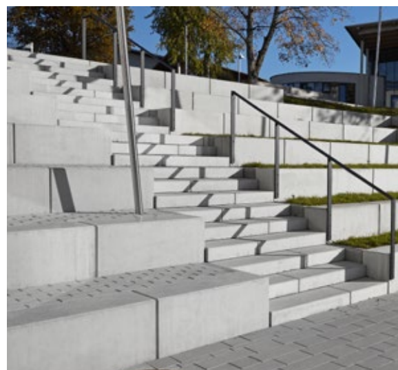
Banc en béton
