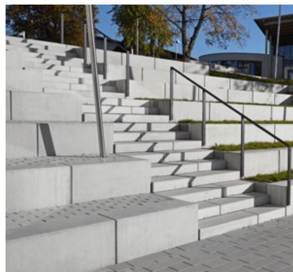
Banc en béton
