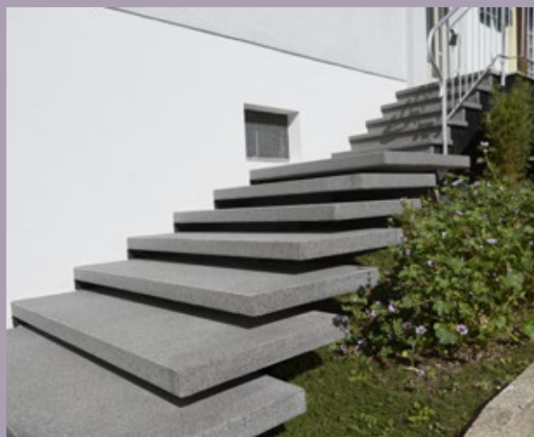
Freitragende Stufenelemente, wirken leicht und schwebend.
