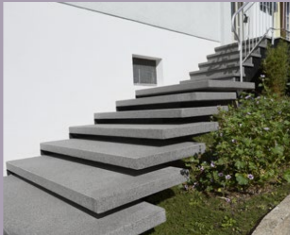
Freitragende Stufenelemente , wirken leicht und schwebend.
