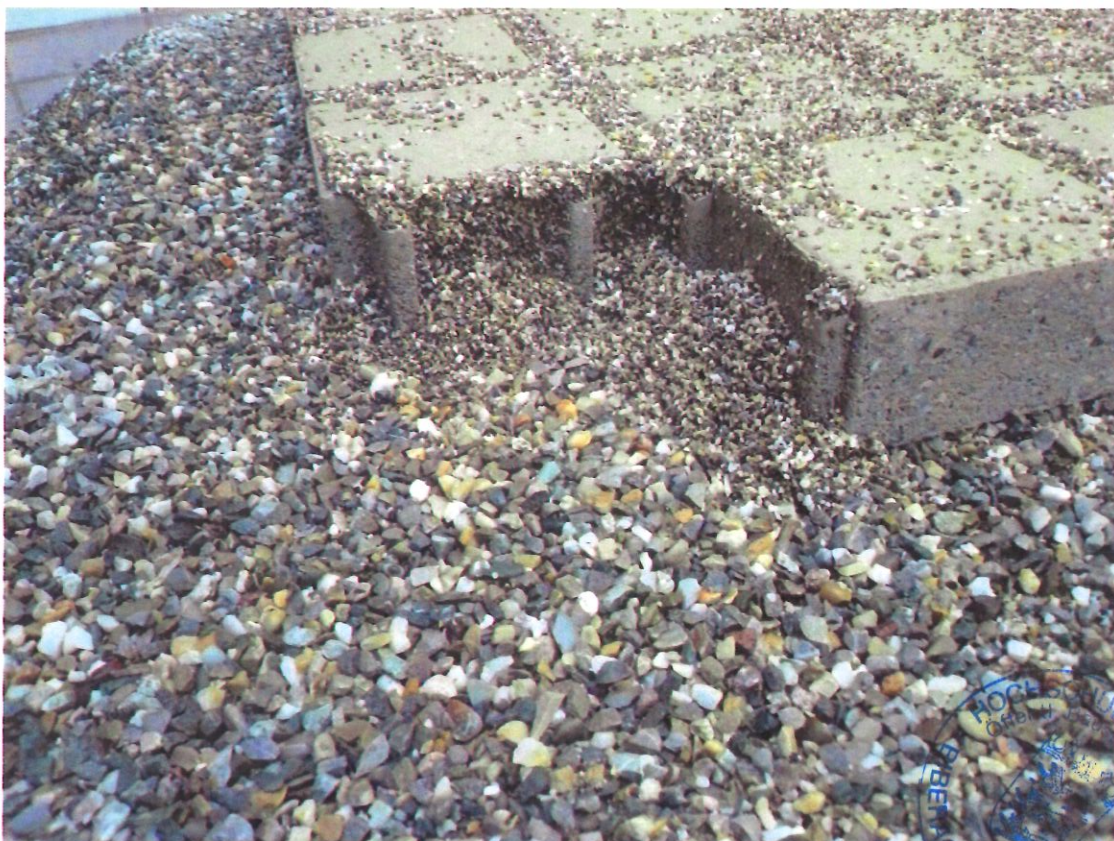
Bild 7: Detailansicht, Fuge nach Bewässerung
