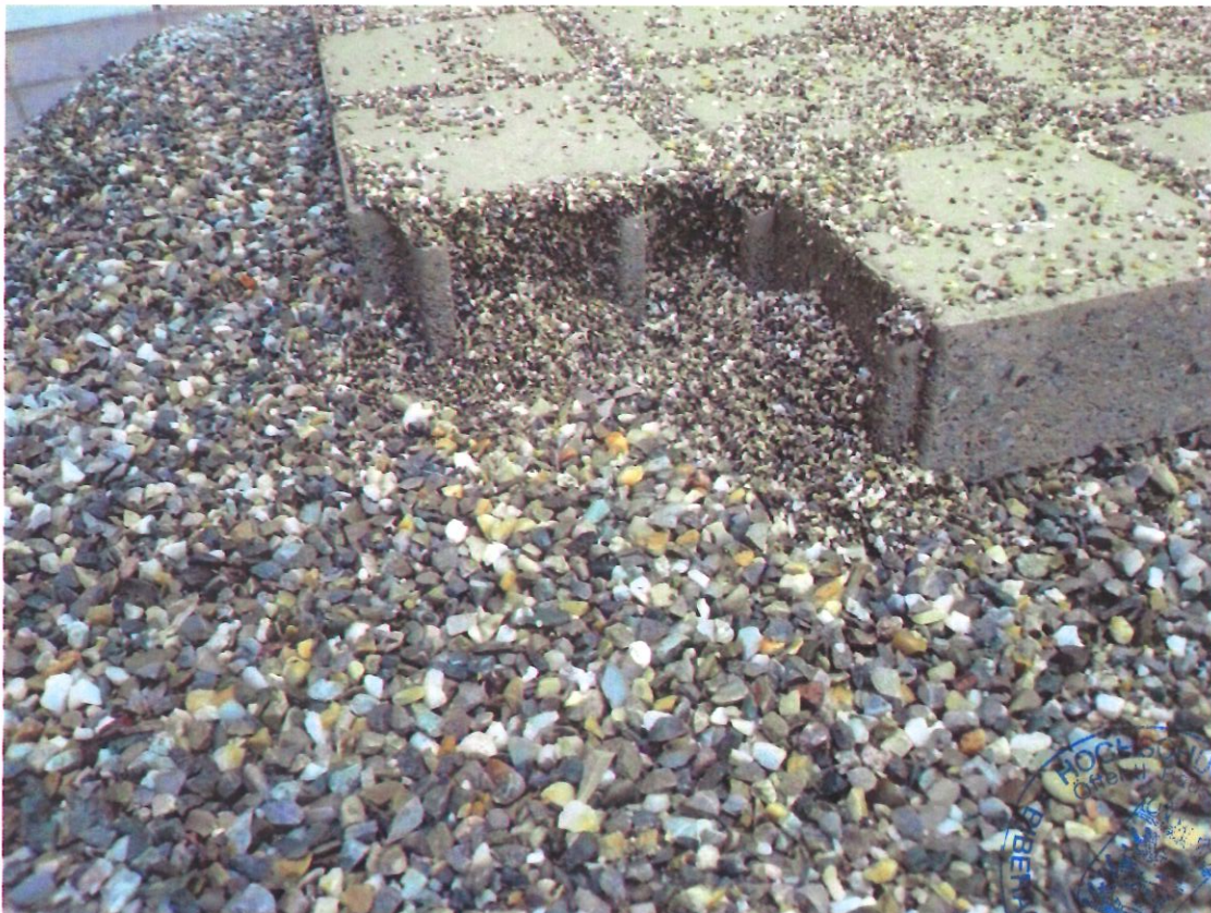
Bild 7: Detailansicht, Fuge nach Bewässerung
