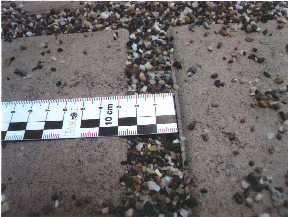
Bild 6: Detailansicht, Fuge nach Bewässerung
