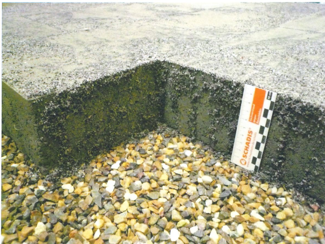
Bild 6: Detailansicht, Fuge nach Bewässerung
