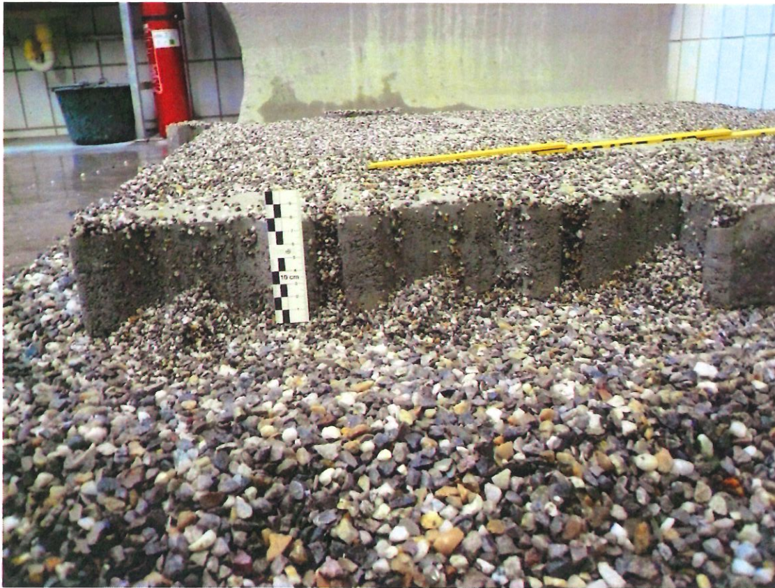
Bild 6: Detailansicht, Fuge nach Bewässerung
